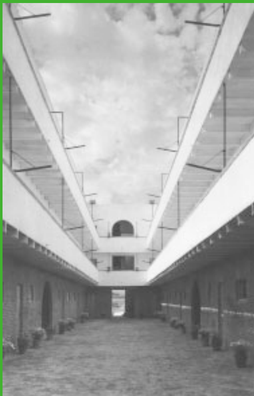
VISTA INTERIOR D'UN ANTIC BLOC DE VIA TRAJANA, 1953 Leopoldo Plasencia (IFEC)
