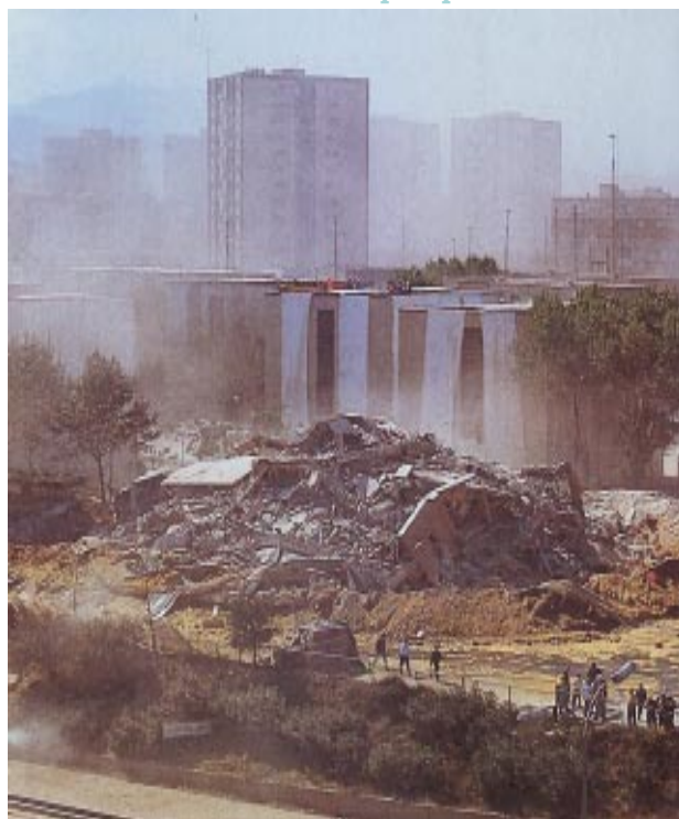
Bombers i tècnics s'apropen a la muntanyeta de runa: el que queda del bloc 80
