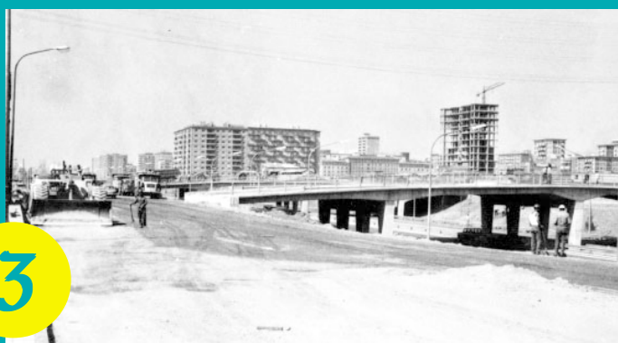
3 CONSTRUCCIÓ DEL 'AUTOPISTA A LA GRAN VIA. 1969 Autor desconegut
