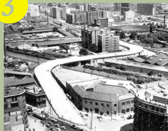
PONT PROVISIONAL QUE UNIA EL CARRER VALÈNCIA AMB EL DE GUÍPÚSCOA. 1964 ANC
