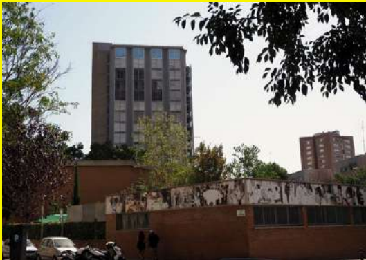
Edifici Piramidón al Barri La Pau
