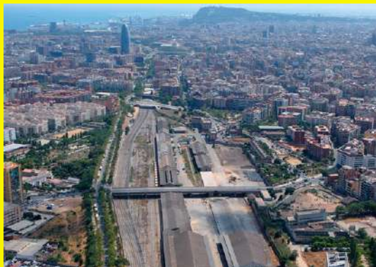
L'estació de la Sagrera, abans de les obres
