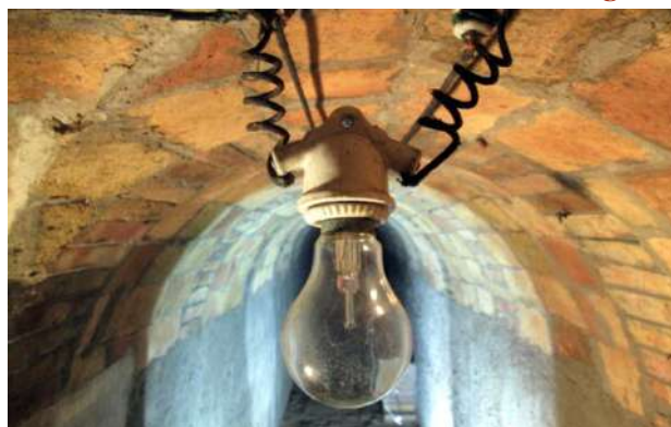
Detall del refugi antiaeri de Torre de la Sagrera
