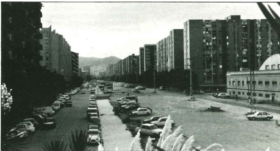
Edificis lineals entre els carrers Pallars i Cristòbal de Moura.
