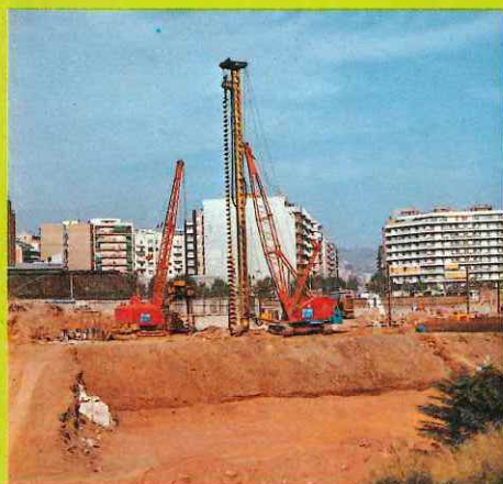
Obres per a la construcció del Pont de Sant Martí
