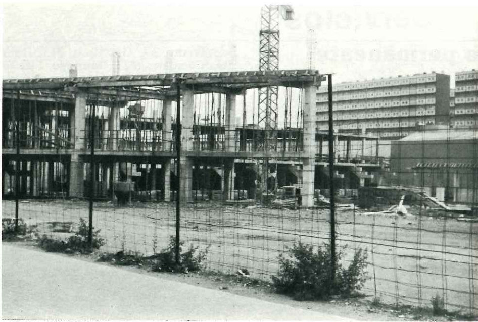
Obras del polideportivo.
