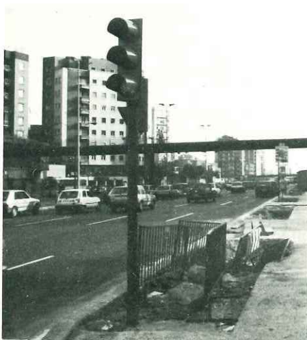
Obras en la Meridiana.
