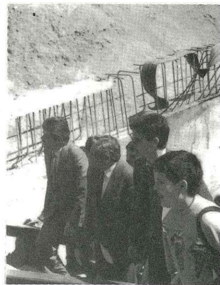
Aspecto exterior de las obras del colector.
