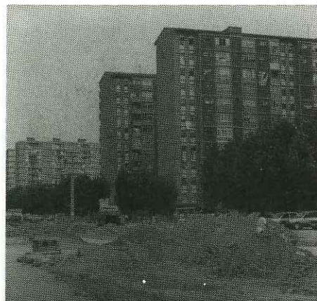
Obras del colector en la Rambla Prim.
